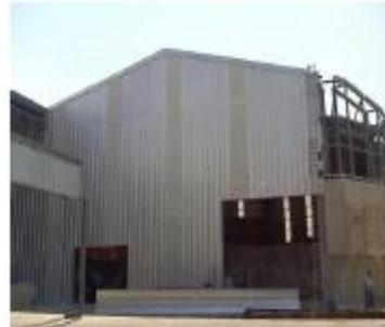
**CUBIERTA EN LAMINA KR18 Y MUROS EN RN100/35.**
