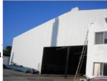
**CAMBIOS DE CUBIERTA EN LAMINA RN100/35 Y MUROS EN LAMINA R101 Y ACRILICOS.**
