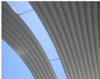
Cubiertas autoportantes formados por arcos metálicos.
