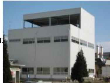
**COLOCACION DE CUBIERTA EN LAMINA KR18, FACHADAS EN RN100/35 Y POLICARBONATOS.**
