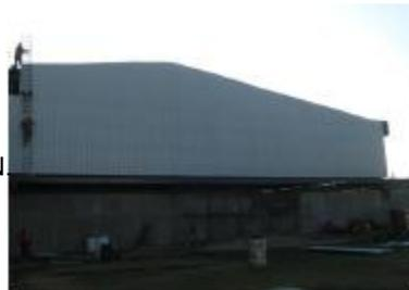
**COLOCACION DE CUBIERTA EN LAMINA KR18, FACHADAS EN RN100/35 Y POLICARBONATOS.**
