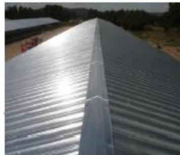
**CUBIERTA EN LAMINA RN100/35 GALVASID Y FOAMULAR 250.**
